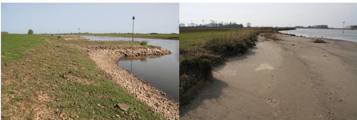
De oevers van de IJssel werden in de jaren '80 van de vorige eeuw grotendeels vastgelegd om erosie door scheepvaartgolven te voorkomen. Recent zijn enkele oevers in het kader van de KRW weer ontsteend (de foto rechts is van een traject nabij Olst, stroomafwaarts van de Gelderse Poort).
