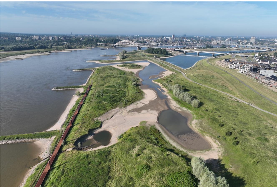
Foto van de (tijdelijk) meestromende Nevengeul bij Lent. Via een smal inlaatwerk wordt weinig water ingelaten. De instroom van de geul is verzand en stroomt bij lage afvoeren niet meer mee.
