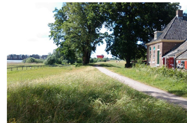
FIG. B.4.4 Dijk langs het Zwarte Water (foto: Michaël van Buuren)
