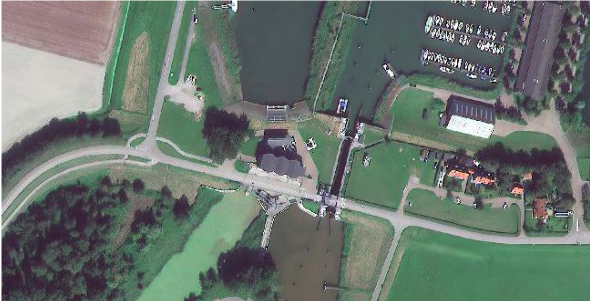
Figuur 3-12: Bovenaanzicht gemaal Colijn aan het Ketelmeer (Bron: satellietdataportaal.nl)
