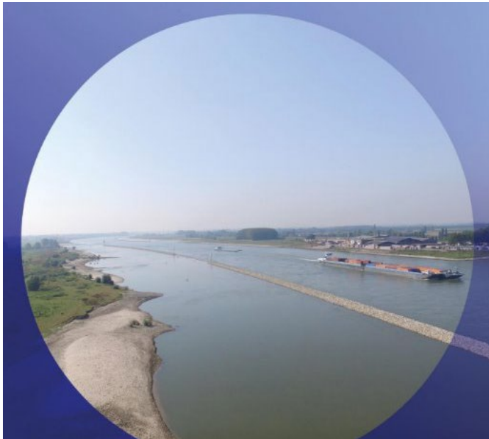
Figuur 5: Bovenaanzicht van de langsdam bij Tiel
